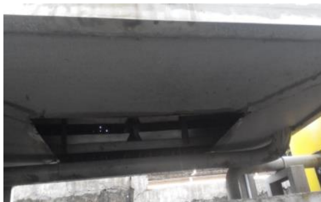
Gambar 5. Silogate sebelum dilakukan perbaikan.
