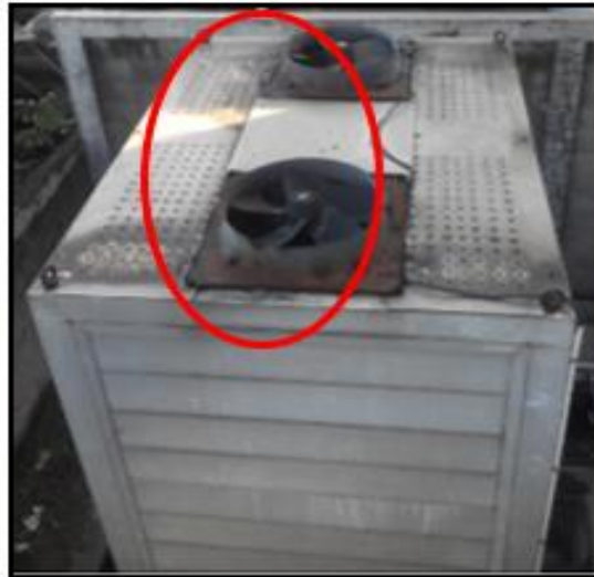
Gambar 4. Fan cooling sebelum dilakukan perbaikan.
