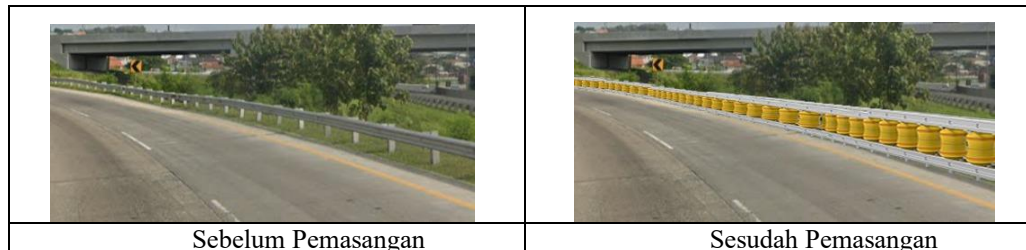
Gambar 4. Pemasangan Rolling Guardrail Di Simpang Susun Krapyak
