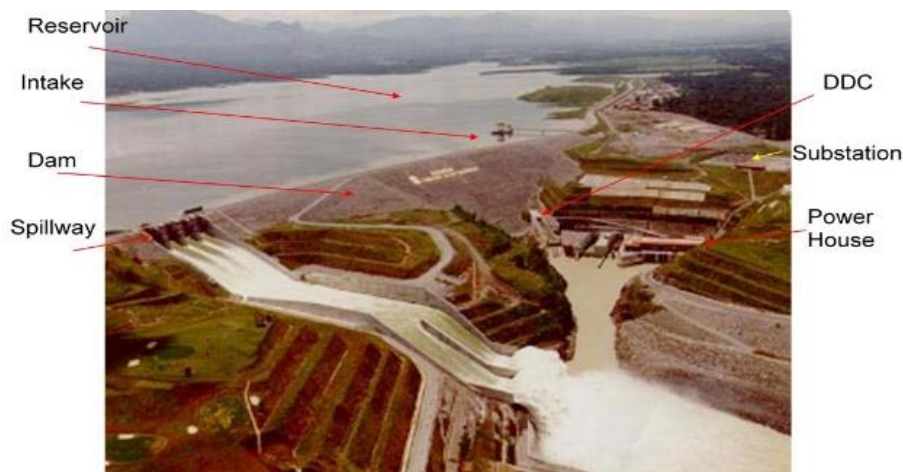
Gambar 3. Posisi Drawdown Culvert pada Proses Flushing [6]
