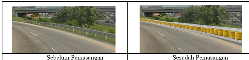
Gambar 4. Pemasangan Rolling Guardrail Di Simpang Susun Krapyak
