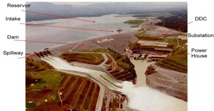
Gambar 3. Posisi *Drawdown Culvert* pada Proses *Flushing* [3]
