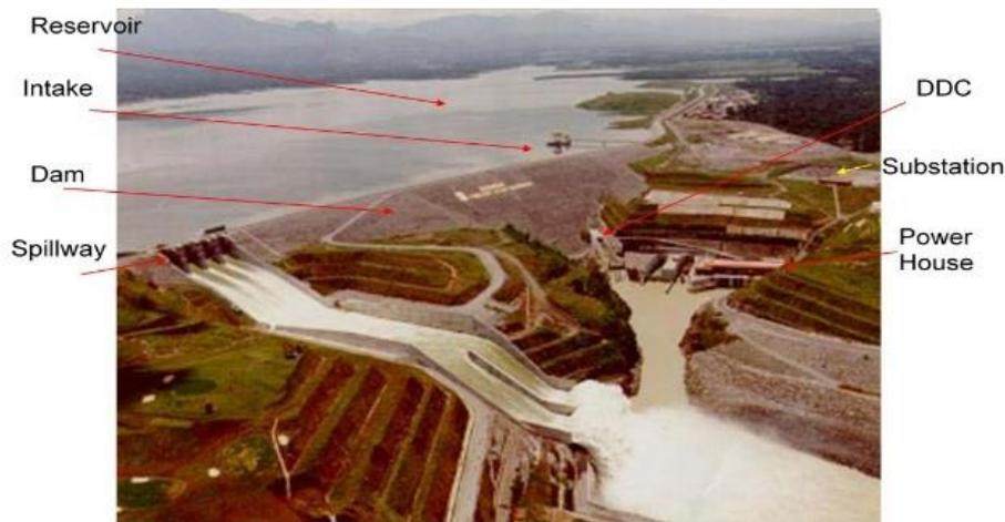
Gambar 3. Posisi *Drawdown Culvert* pada Proses *Flushing* [6]
