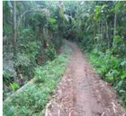
Gambar 7. Salah satu kondisi ruas jalan penghubung antar desa yang berbukit bergelombang di Desa Kedarpan Kecamatan Kejobong (Foto diambil tanggal 2 Februari 2013 pukul 16.30)
