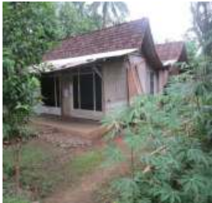
Gambar 6. Salah satu kondisi rumah penduduk Desa Kedarpan Kecamatan Kejobong (Foto diambil tanggal 2 Februari 2013 pukul 16.30)
