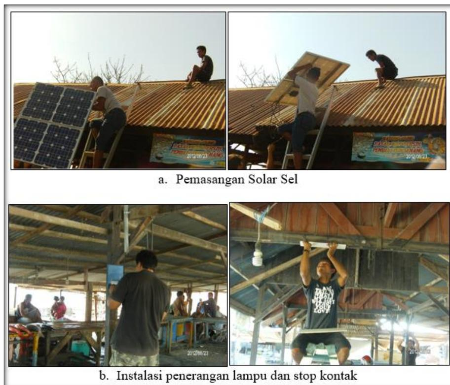
Gambar 6. Pemasangan Solar Sel dan Instalasi Penerangan
