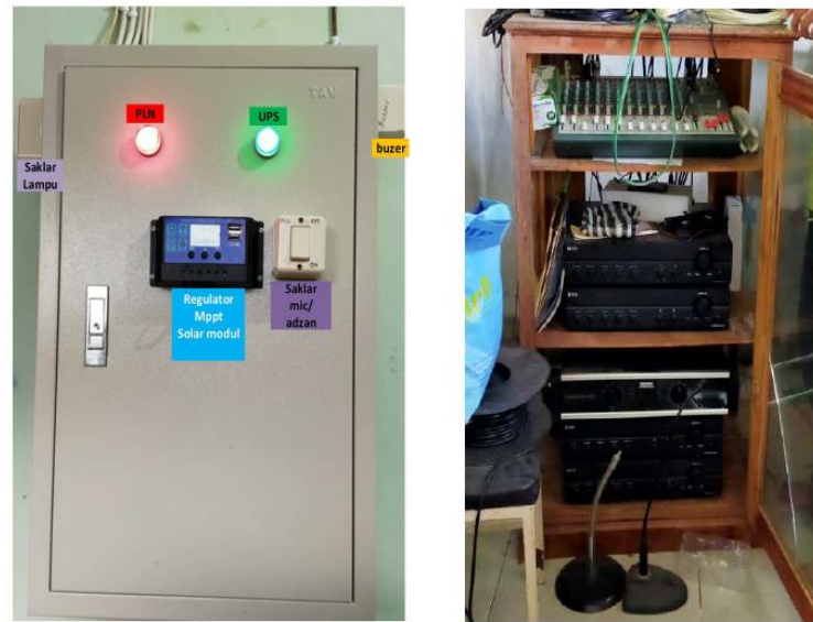
Gambar 3. Pemasangan Panel Kontrol, UPS, Baterai dan Instalasi
