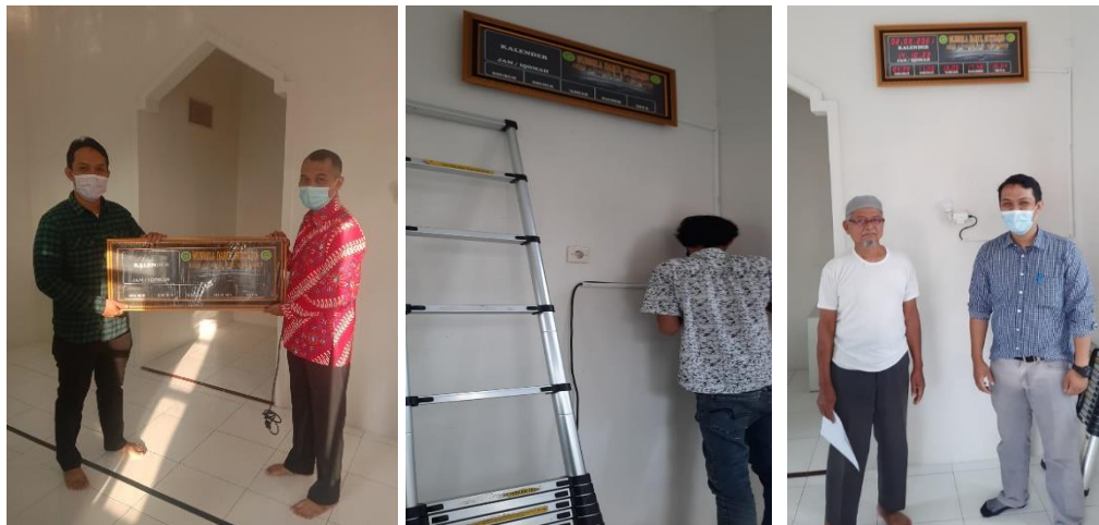
Gambar 6. Dokumentasi Instalasi dan Training Jadwal Sholat Digital
