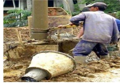
Gambar 9. Pemasangan Pipa Tremi
