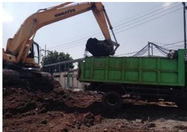
Gambar 14. Pekerjaan Pembuangan Tanah
