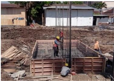
Gambar 13. Pekerjaan Pembuatan *Pile Cap*
