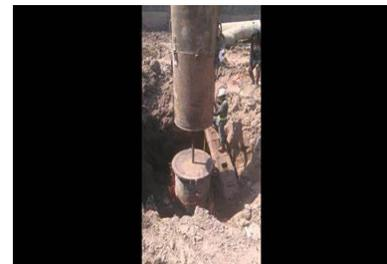
Gambar 6. Pemasangan Casing
