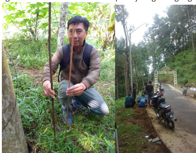
Gambar 2. Penggantian rod grounding
