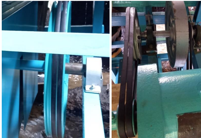
Gambar 5. Pemasangan V-belt dan bearing.
