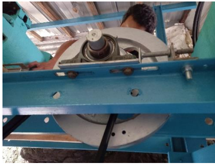
Gambar 4. Pemasangan flywheel pada poros generator.
