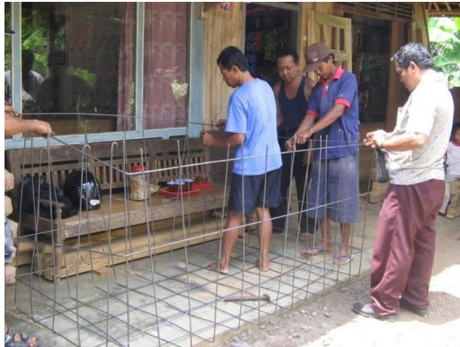
**Gambar 3.** Pembuatan bak penampung
