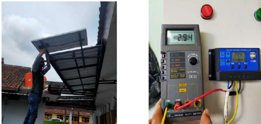
Gambar 2. Pemasangan Solar Modul dan Regulator Charging Baterai
