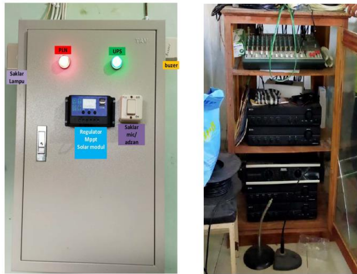
Gambar 3. Pemasangan Panel Kontrol, UPS, Baterai dan Instalasi
