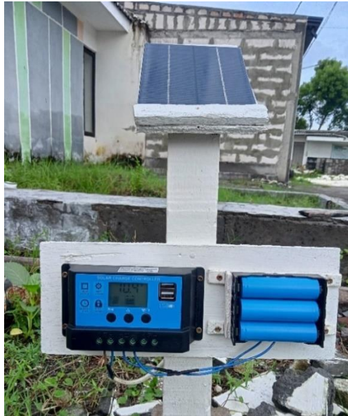
Gambar 7. Pengujian Panel Surya
