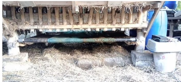
Gambar 5. Pemasangan Konveyor dan Prototipe Pengendali Otomatis pada Kandang.
