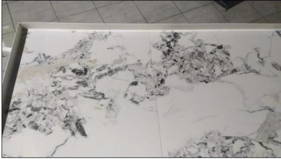
Gambar 6. Bagian Permukaan Meja Menggunakan Granit
